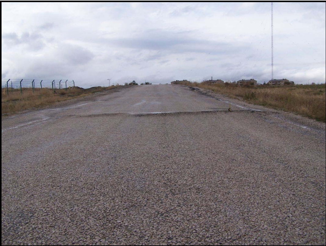
Foto A2. Yüzüncü Yıl Üniversitesi-Topaktaş yolunda asfalt zeminde izlenen (L3) sıkışma deformasyonu. Bakış KB'yadır.
