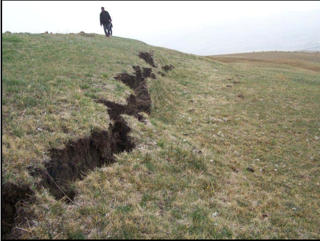
Foto C4. Çomaklı doğusunda eski kayma alanlarında yeniden aktivite kazanmış ikinci gerilme çatlakları. Bakış doğuyadır.
